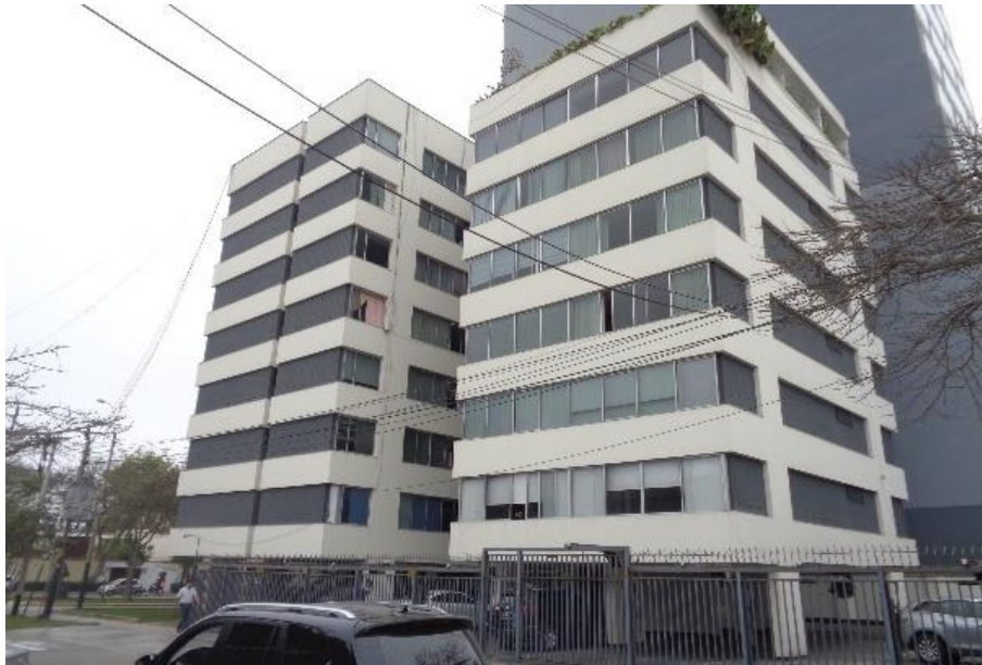
Figura 28. Vivienda de pórticos de concreto armado (C1).
