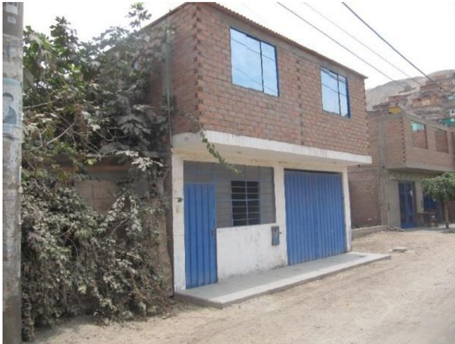
Figura 26. Vivienda informal de albañilería (M3).
