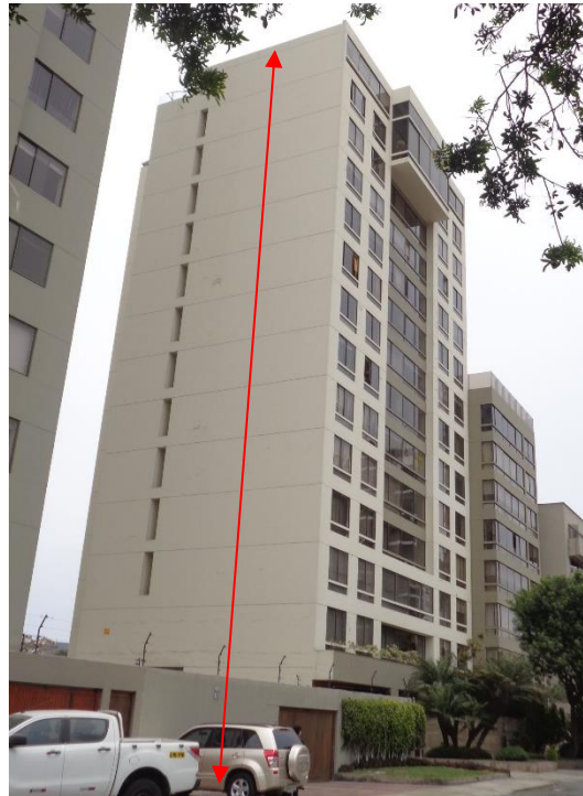
Figura 8. Identificación de muros de concreto.
