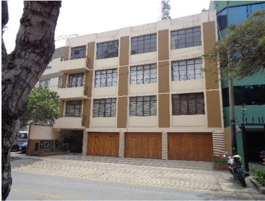
Figura 30. Vivienda de pórticos de concreto armado rigidizados con muros de albañilería (C3).
