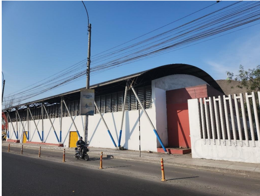
Figura 34. Estructura con perfiles livianos de acero (A3).
