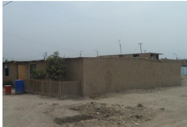
Figura 15. Tipología estructural AQ: Adobe y Quincha.
