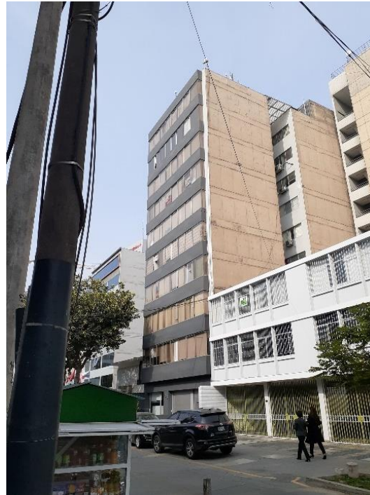
Figura 29. Vivienda de muros de concreto armado (C2).
