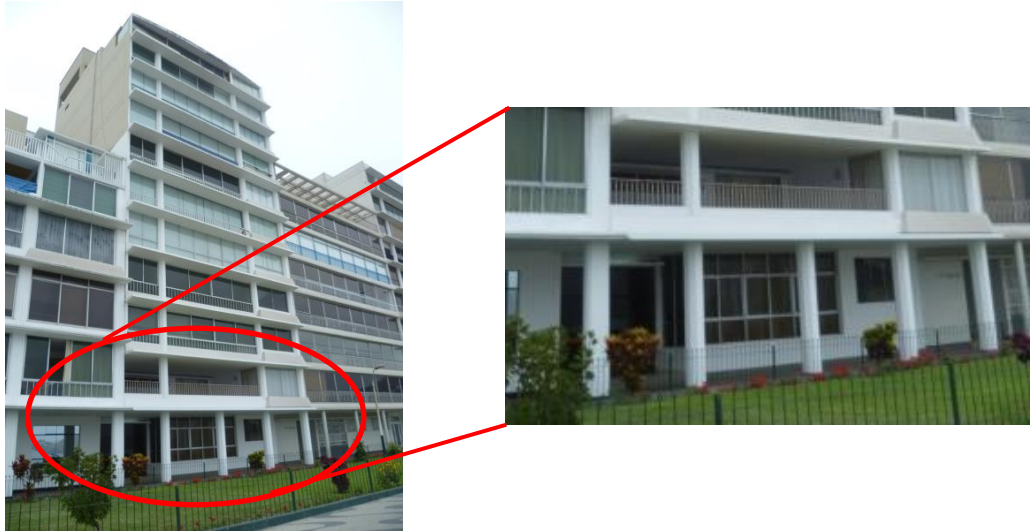
Figura 4. Identificación de columnas de concreto armado.
