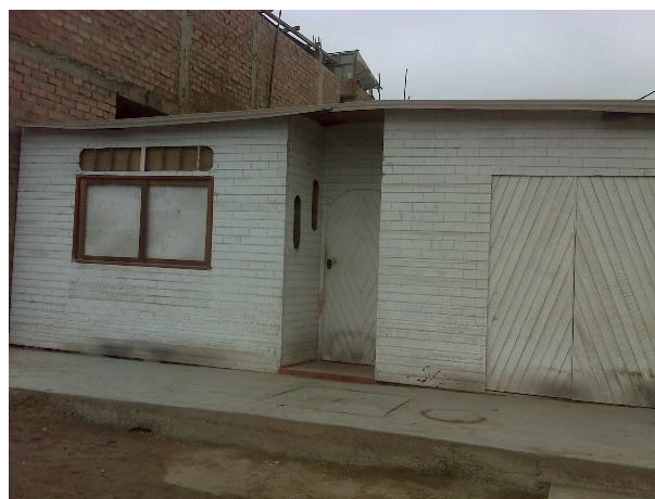
Figura 18. Tipología estructural EM: Entramados de madera.
