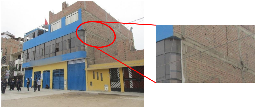
Figura 6. Identificación de losas rígidas de entrepiso.
