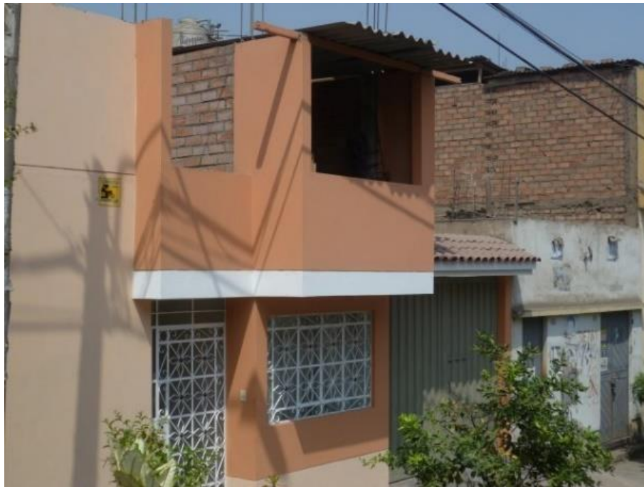
Figura 25. Vivienda de albañilería confinada con diafragmas flexibles (M2F).
