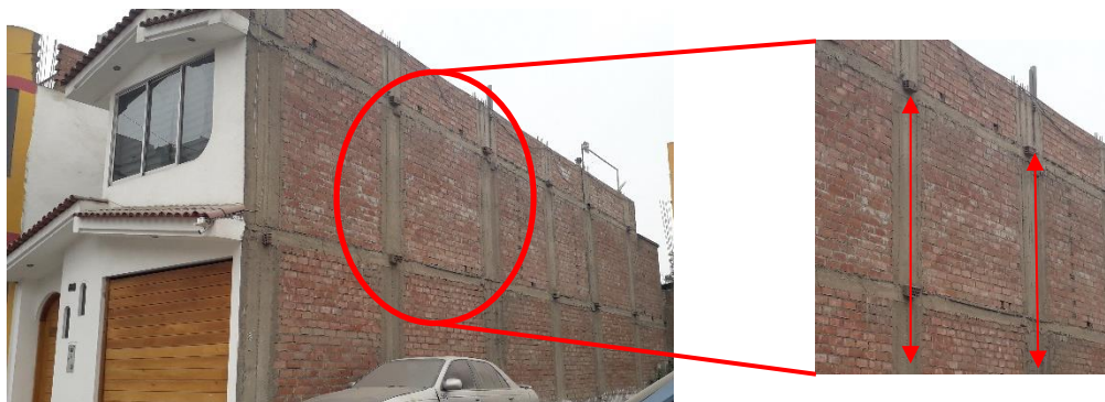
Figura 5. Identificación de columnas de confinamiento
