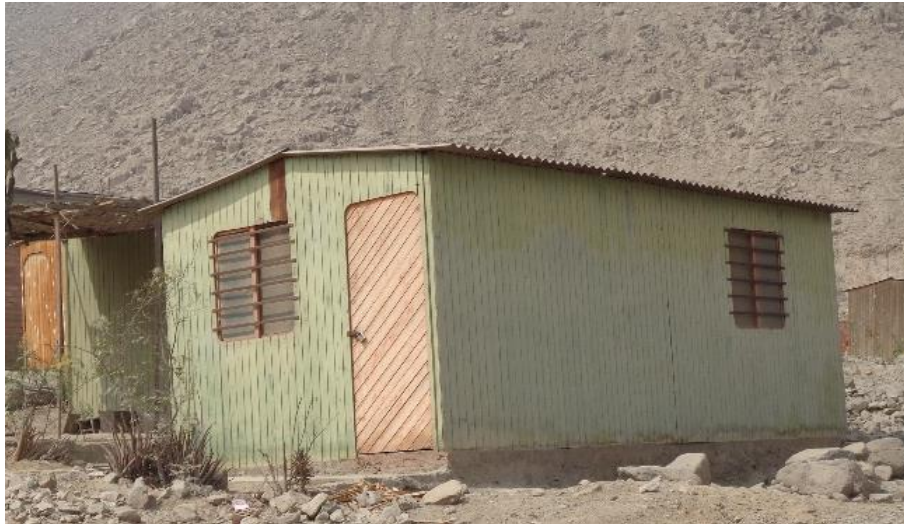
Figura 35. Vivienda de entramados de madera (EM)
