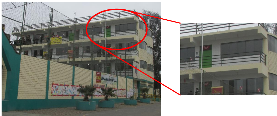
Figura 7. Identificación de vigas de concreto.
