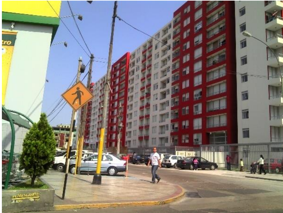
Figura 31. Vivienda multifamiliar con muros de ductilidad limitada (C4).
