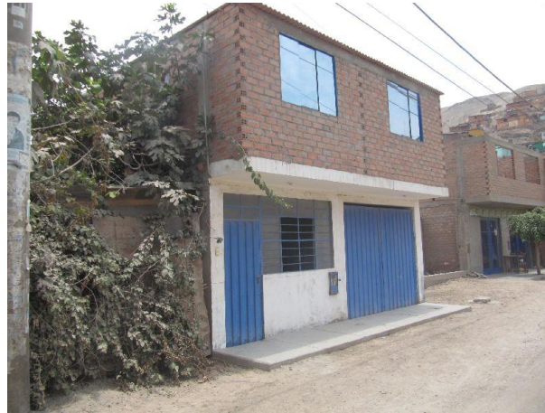
Figura 11. Vivienda con albañilería informal o no ingenieril.
