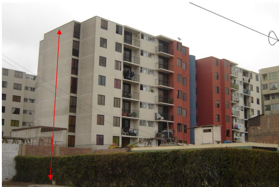
Figura 9. Identificación de muros de ductilidad.
