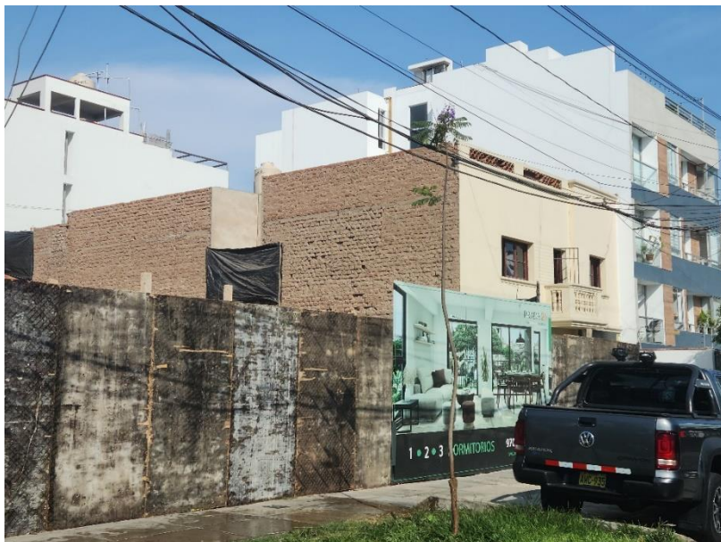
Figura 23. Vivienda de albañilería de arcilla sin refuerzo (M1).
