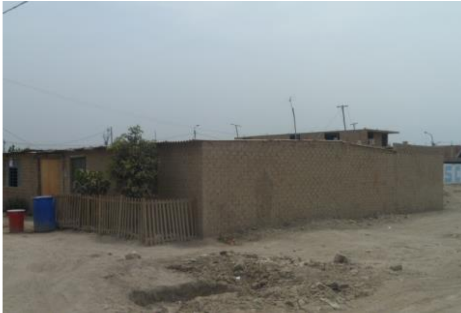
Figura 27. Vivienda de adobe y quincha (AQ).
