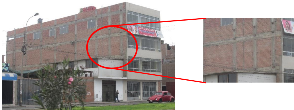
Figura 10. Identificación de muros de albañilería.
